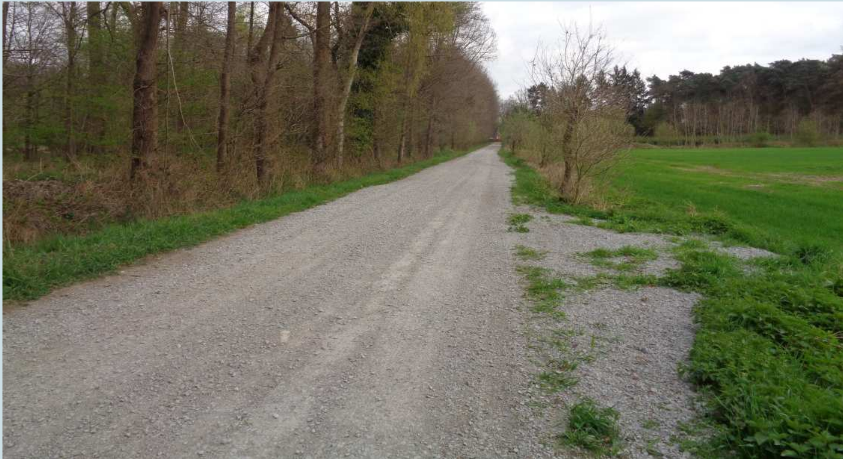
Bereich Galgheide vor dem Ausbau
